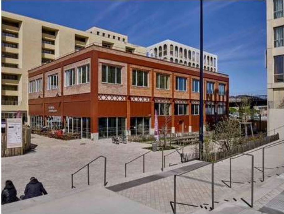
L'Atelier des Citernes de l'extérieur. Crédit Atelier Caumes.
