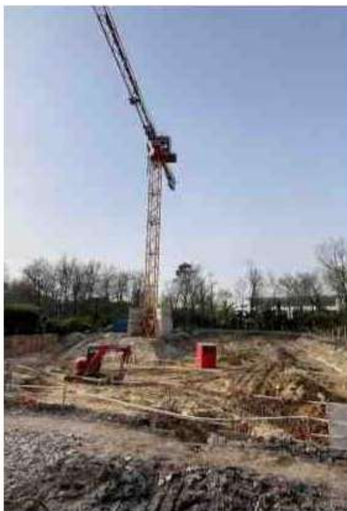
La construction a commencé en janvier. - É. L.
