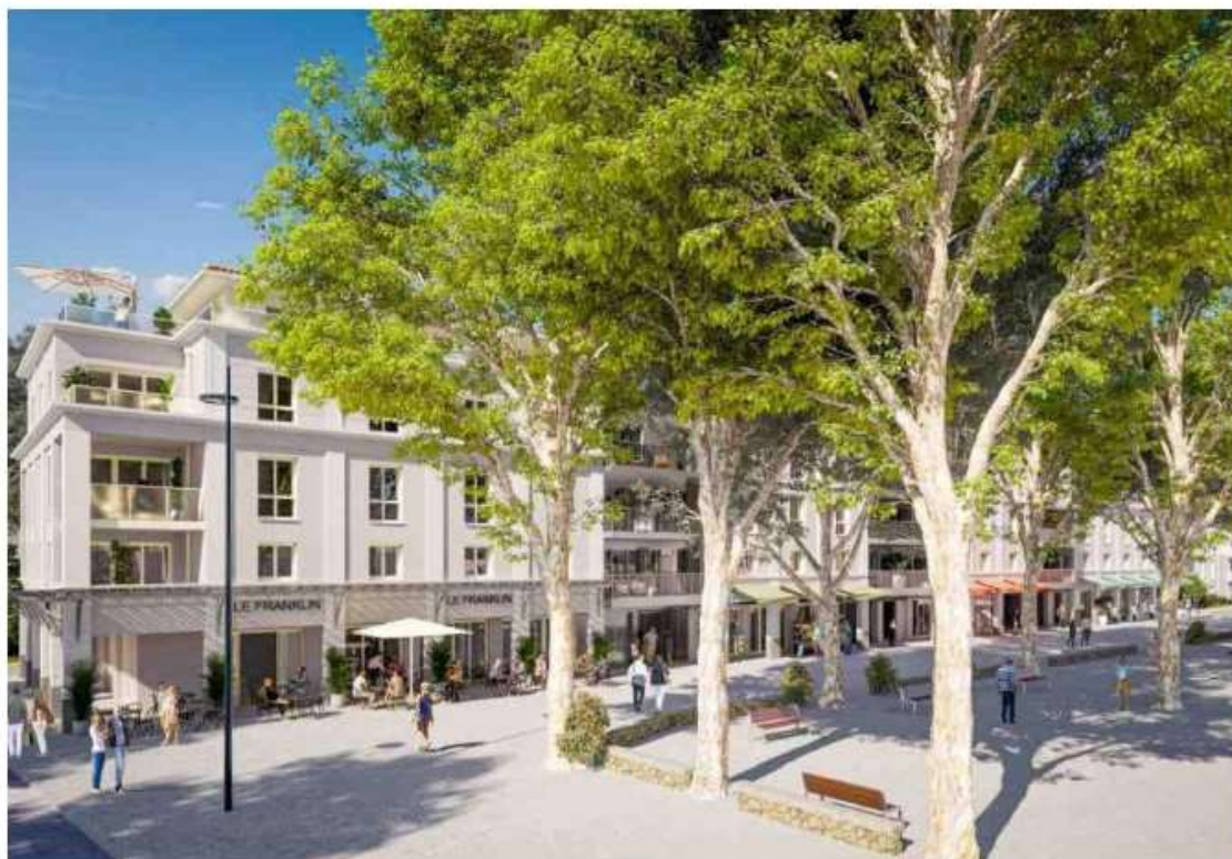
Le projet du futur îlot Gambetta. En bas à gauche, le chantier en cours à Cazaux sur l'emplacement de l'ancien stade. En bas à droite, la nouvelle façade du conservatoire de musique. - VILLE DE LA TESTE-DE-BUCH ET CLAUDE PETIT / SO
