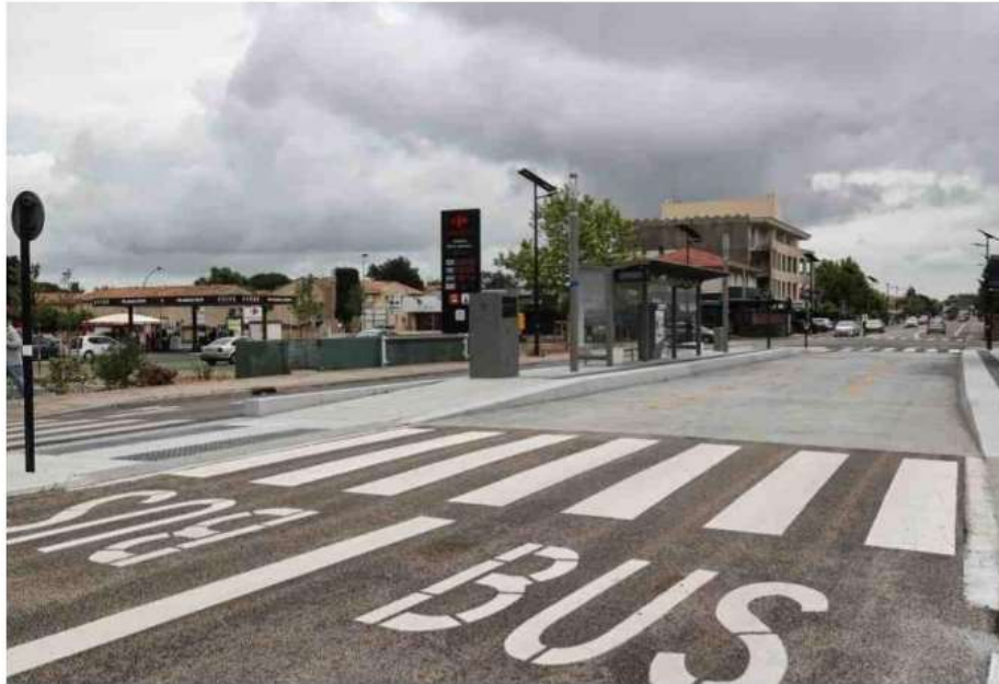
La station du bus express, arrêt Caillou, fin prête à hauteur du Carrefour Contact, avenue de Lattre-de-Tassigny à Bordeaux.
